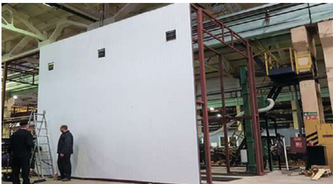
Монтаж сэндвич-панелей камеры
