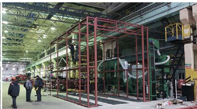
Монтаж сборной металлоконструкции обитаемой дробеструйной камеры
