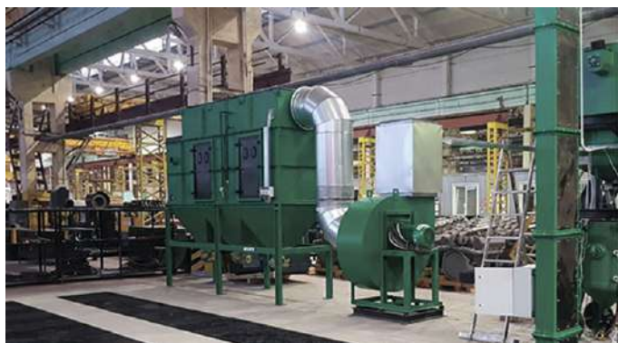
Монтаж фильтра, пневмомеханической системы сепарации, вертикального элеватора
